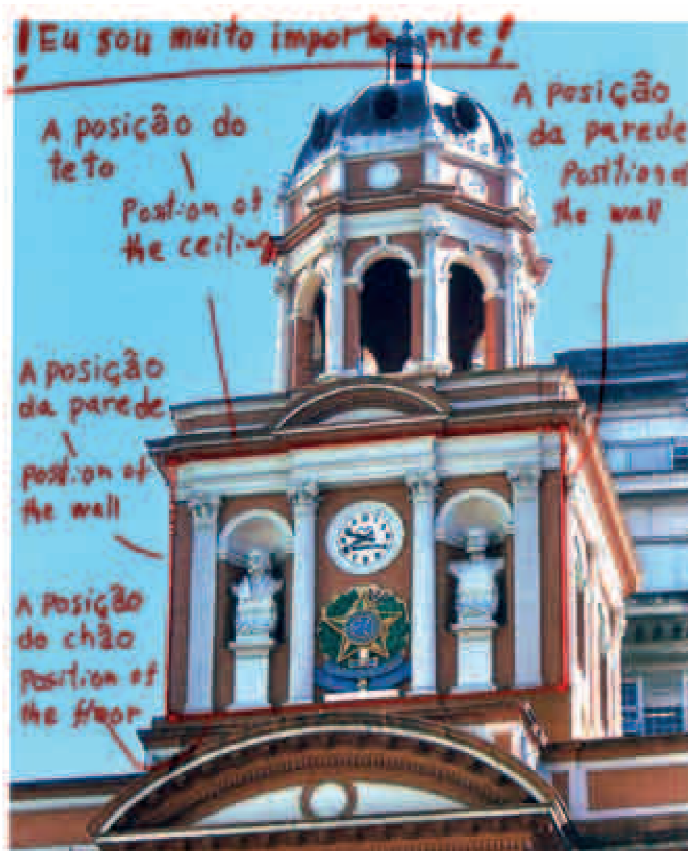
Detalhe da fachada da Prefeitura Velha de Porto Alegre. 2011. Projeto.
