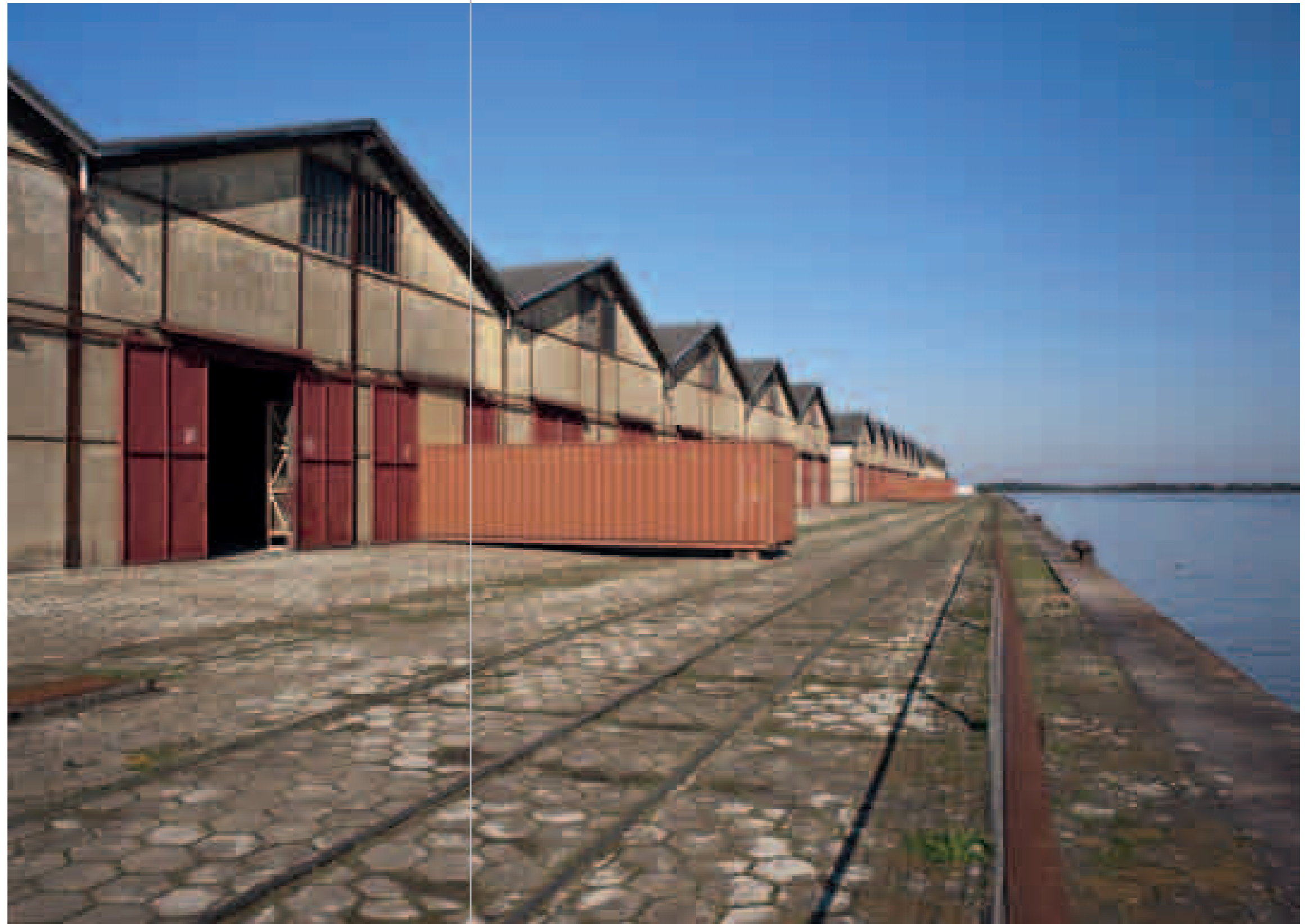
Construção das ZAPs nos armazéns do Cais do porto. 2011.
